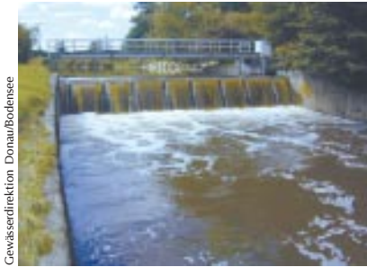
Nicht durchgängiges Wehr an der Riß.
