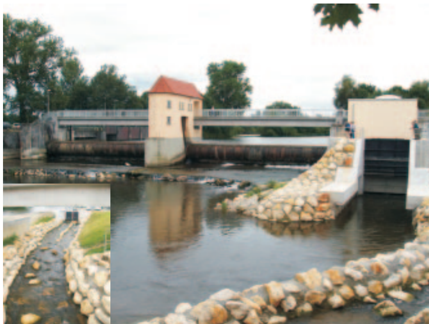
Das Wehr Ersingen an der Donau und der neue Fischweg.
